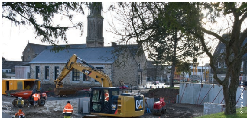
Aménagement du futur city stade, derrière Le Pollen.
