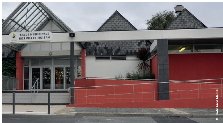
Rampe d'accès à la salle des Villes Moisan.
